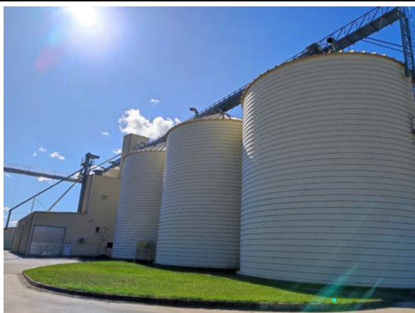
A major északi részén álló nagy silók
